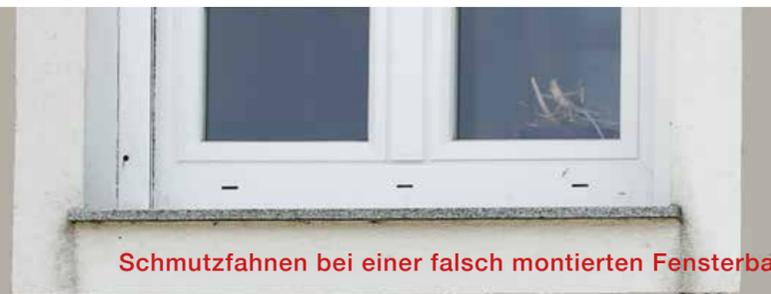
**Schmutzfahnen bei einer falsch montierten Fensterbank ohne Anschlussystem!**
